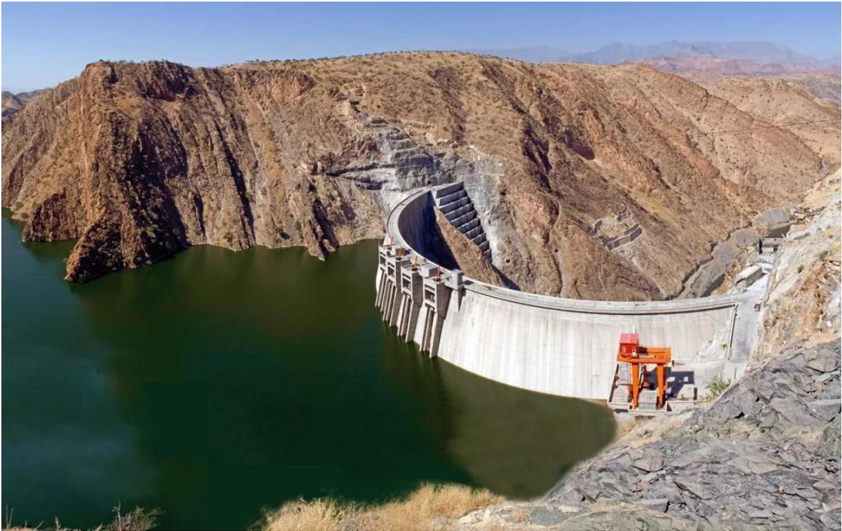
该电站共安装 4 台 7.5 万千瓦机组，总装机容量 30 万千瓦，坝高 188 米，是非洲最高的混凝土双曲薄拱坝，被称为埃塞俄比亚的“三峡工程”。创造了拱坝无一条裂缝的奇迹，埃塞俄比亚特克泽水电站是首个获得中国建筑领域最高奖“鲁班奖”的海外水电项目。
