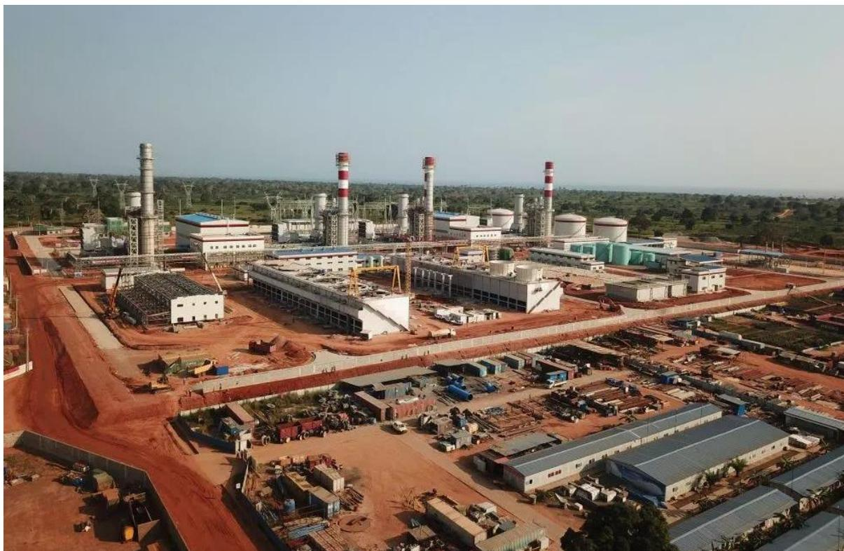
自 2017 年 7 月竣工投产后一直平稳运行。该项目新建 2 套 209E 燃气联合循环发电机组，总装机容量 75 万千瓦。
